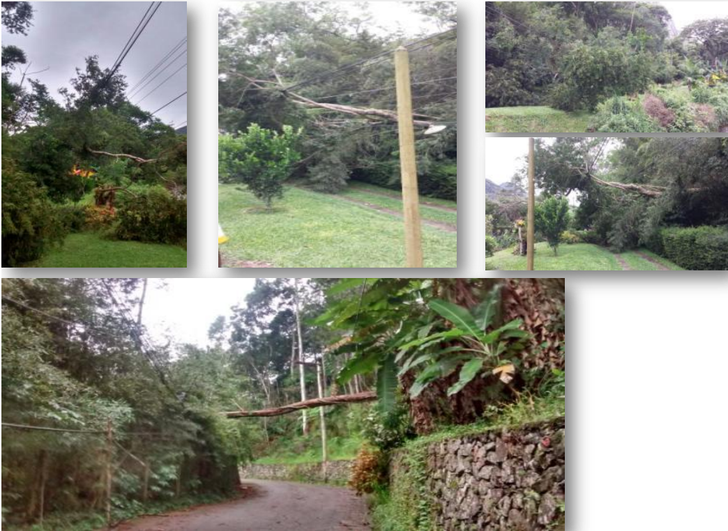
Conjunto: Rio da Cidade Causa: Queda de árvore
